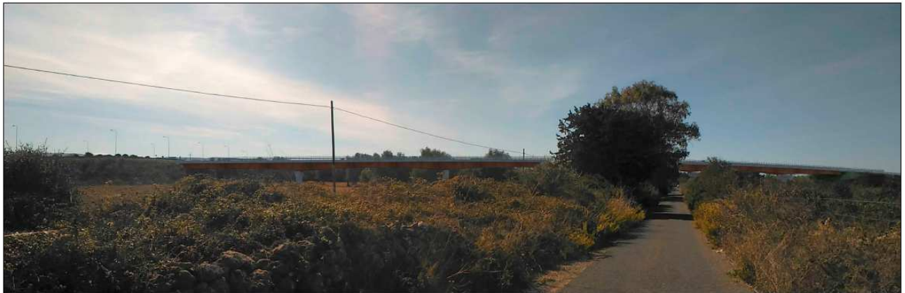
PONTE FERROVIARIO - post operam
